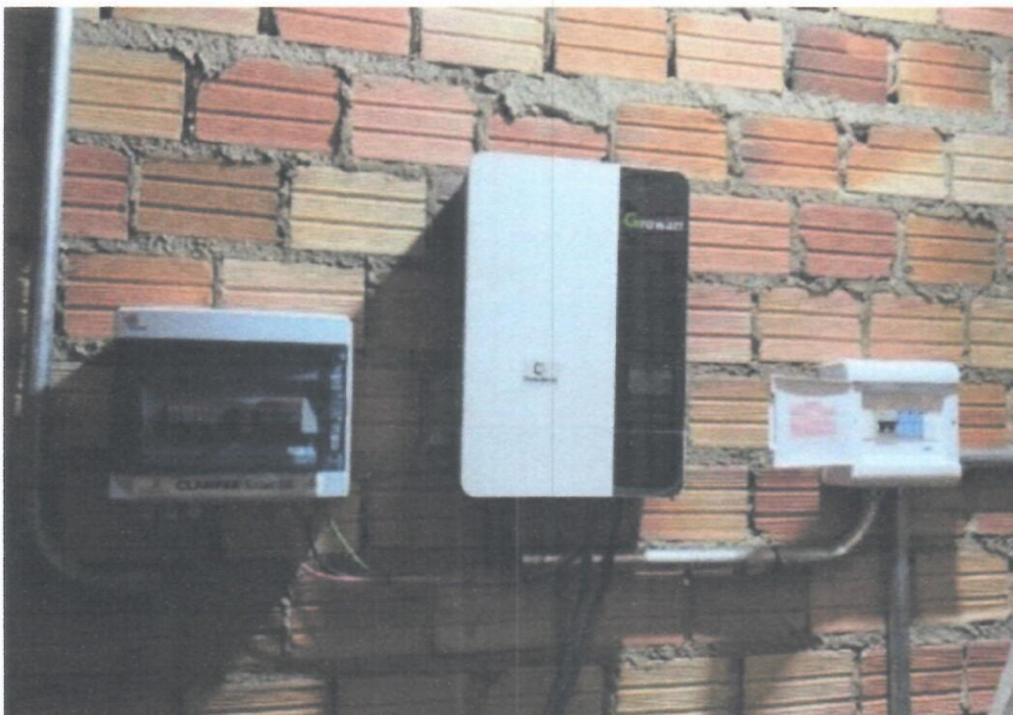
**Figura 10.** Inversor e quadros com disjuntores.
