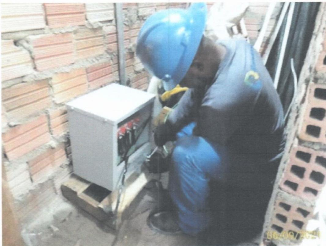
**Figura 13.** Instalação do transformador de energia.
