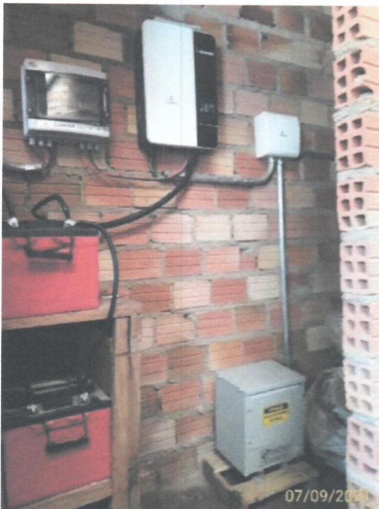
**Figura 14.** Sistema de recepção e transformação de energia gerada com o sistema fotovoltaico.
